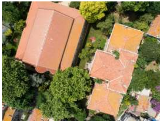
Φωτογραφία στέγης της Σχολής (δεξιά) που λήφθηκε από drone. Αριστερά ο Ι.Ν. Αγ. Δημητρίου
